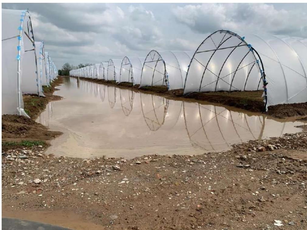
***PRESENZA DI ACQUE IN ASSENZA DELLA LINEA DI COLLEGAMENTO AL BACINO DI SMALTIMENTO DELLE ACQUE METEORICHE***
