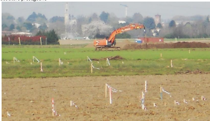
La tracciatura nei campi del sedime autostradale
